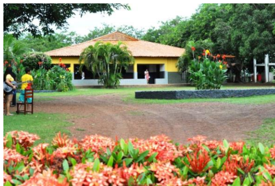
Centro de Atendimento
